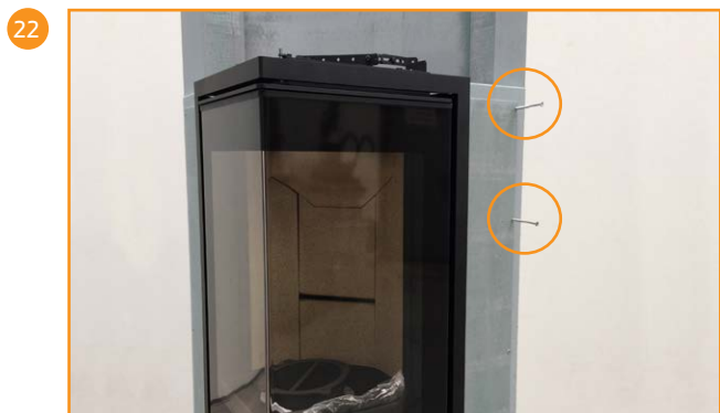
Sidestykkene limes og skrues fast til bakstykket med to skruer
