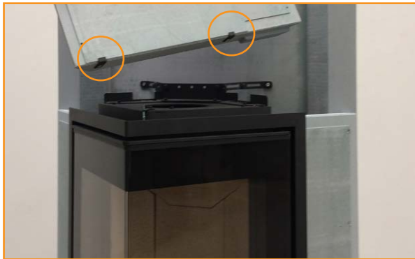
De to øvre frontstykkene monteres med to beslag
