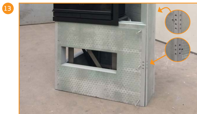
Deretter monteres det samlede bakstykket med fronten med lim og tre skruer i hver side
