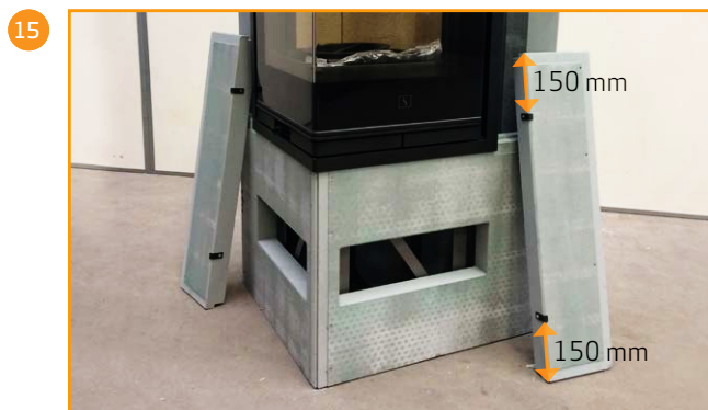
Sidestykkene monteres med to beslag OBS: Disse har ikke noe hullmønster!
