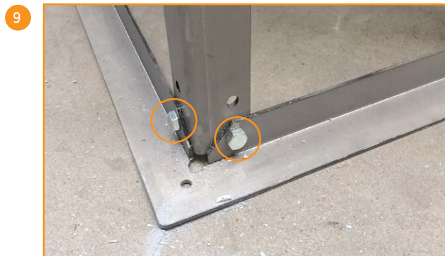
Det er viktig at baksiden av omrammingsplatene ligger an mot bolthodet når disse monteres!
