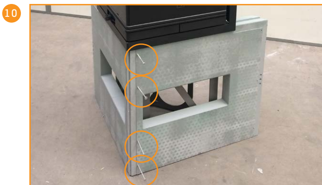
Frontstykkene skrues sammen med fire skruer
