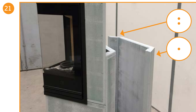
De tre øvre bakstykkene limes sammen med sidestykkene og skrues sammen med tre skruer
