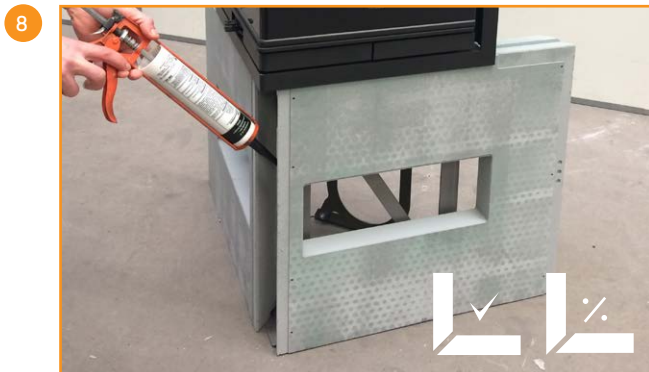
Frontstykkene skyves og limes sammen, slik at de ligger helt i flukt med hverandre
