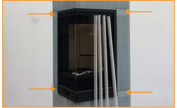
Selvklebende nettbånd monteres i sparkelsporet. Klipp deretter til kantlister med en stor saks
